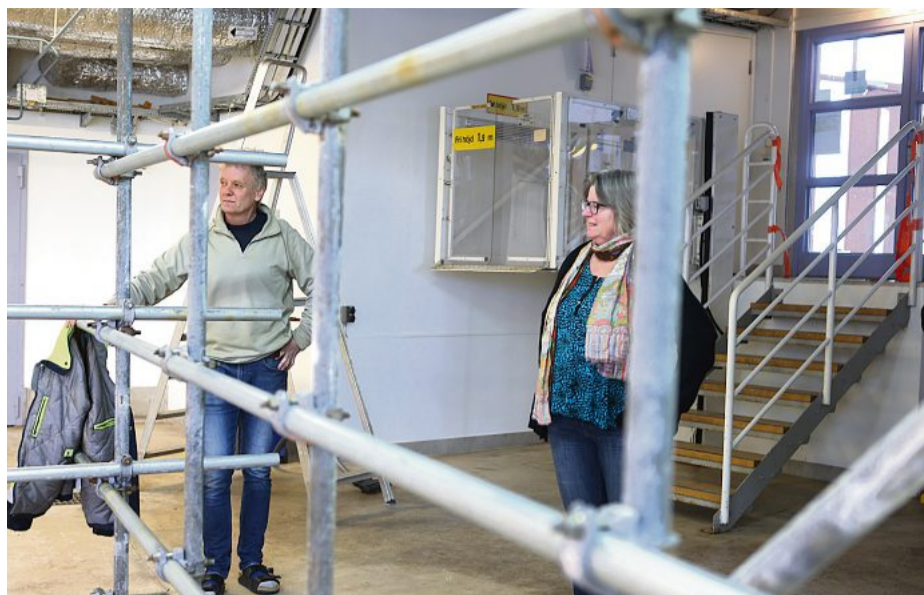
Lars Vallin och Gunilla Rosenqvist vid ställningarna som ska bli två helt nya bassänger inne på forskningsstationen i Ar.
