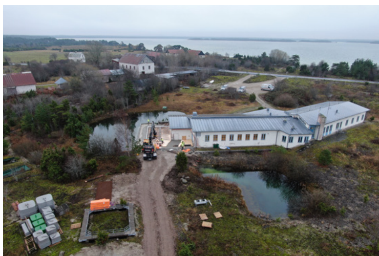
Inför jul 2020 var arbetet i full fart med att gjuta en bottenplatta för det framtida kylrummet. Kylrummet kommer utgöra den plats där torskarna leker, med en temperatur på 7 grader Celsius – ungefär motsvarande den temperatur som råder i Bornholmsdjupet under torskens lekperiod. Foto: Lars Vallin
